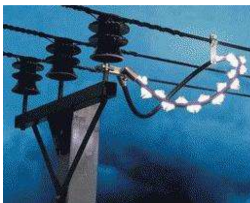
Рисунок 4.4 – Фотография и схема подключения РДИП
