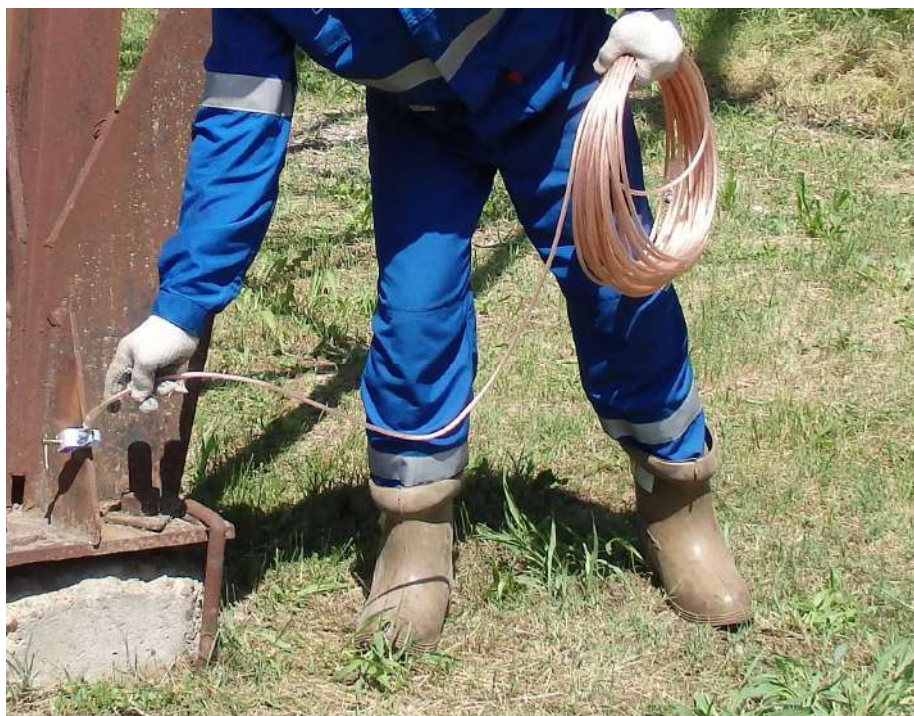
Рисунок 3.17 – Работа в диэлектрических ботах
