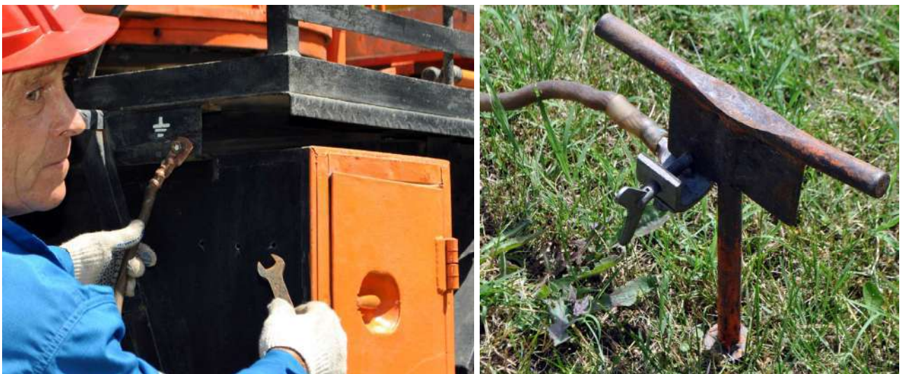
Рисунок 3.11 – Схемы уравнивания потенциалов с использованием заземляющего электрода
