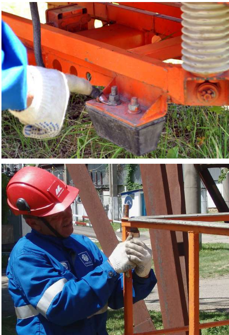
Рисунок 3.10 – Шунтирование изоляторов корзины
