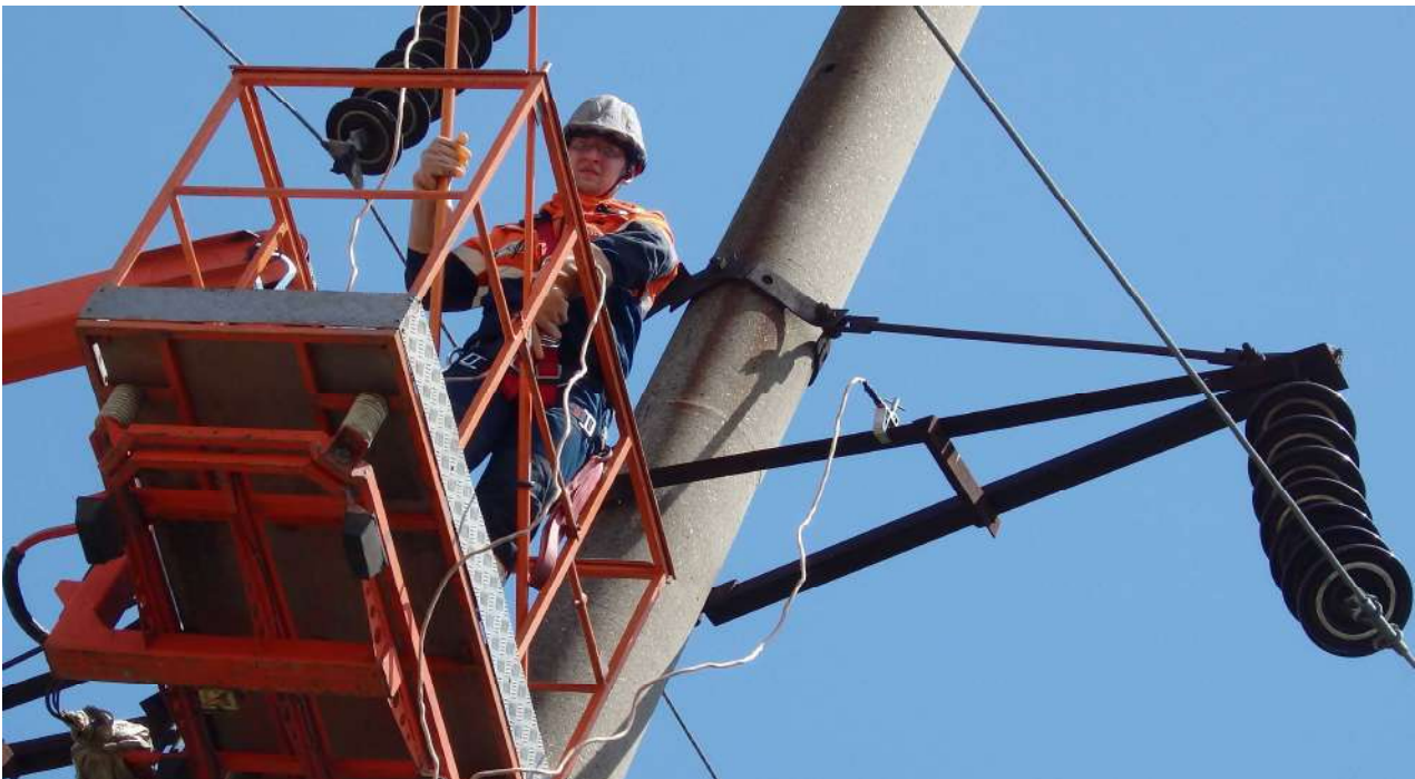
Рисунок 3.14 – Соединение электрода с траверсой опоры отключенной ВЛ
