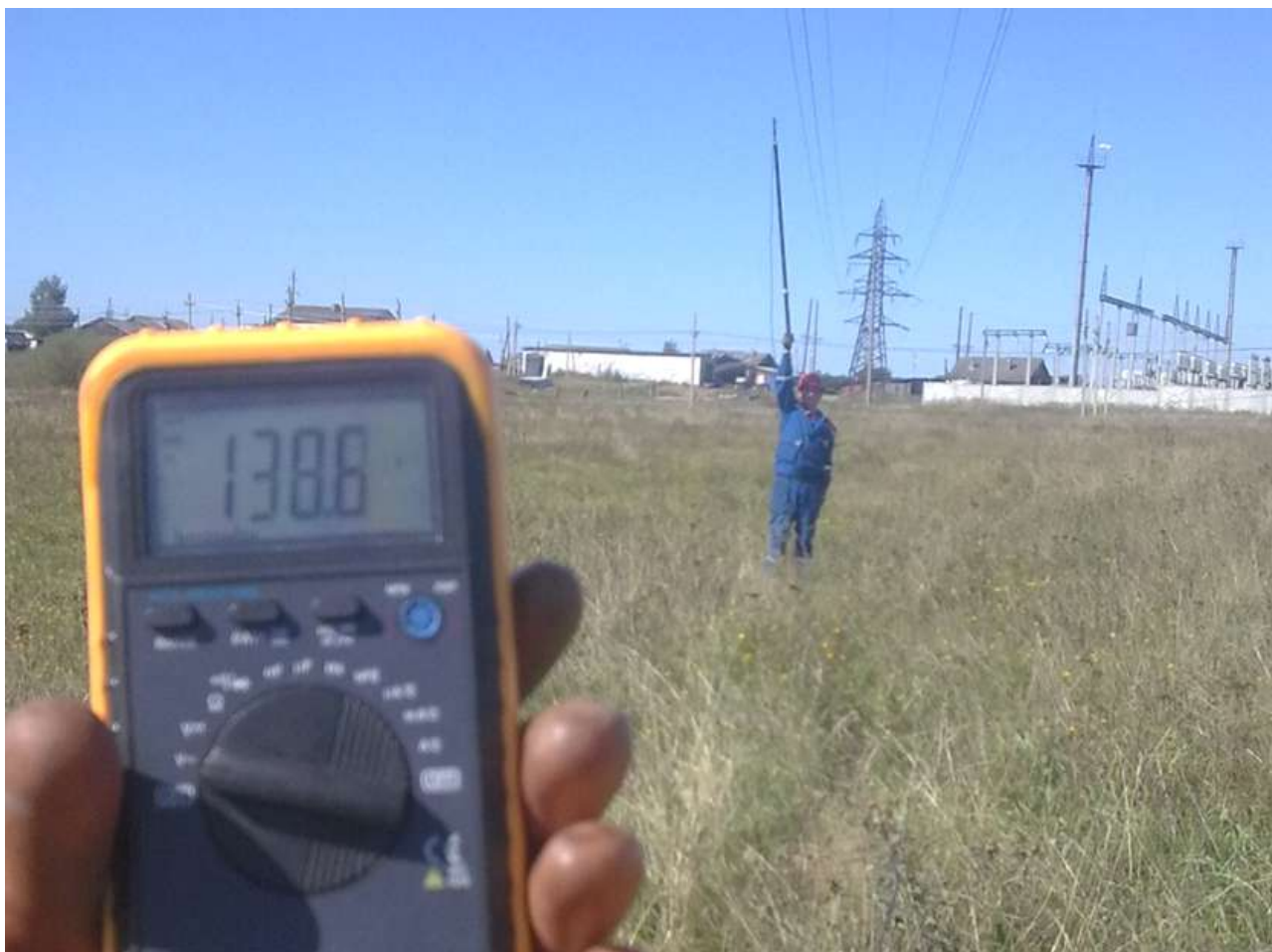
Рисунок 1.1 – Наведенное напряжение на изолированном проводе длиной 20 метров, протянутом вдоль ВЛ-110 кВ, составило более 138 В
