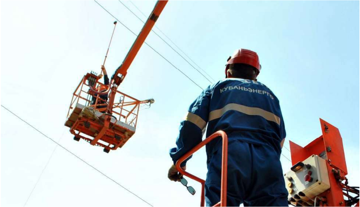
Рисунок 3.13 – Заземление нижнего провода отключенной ВЛ
