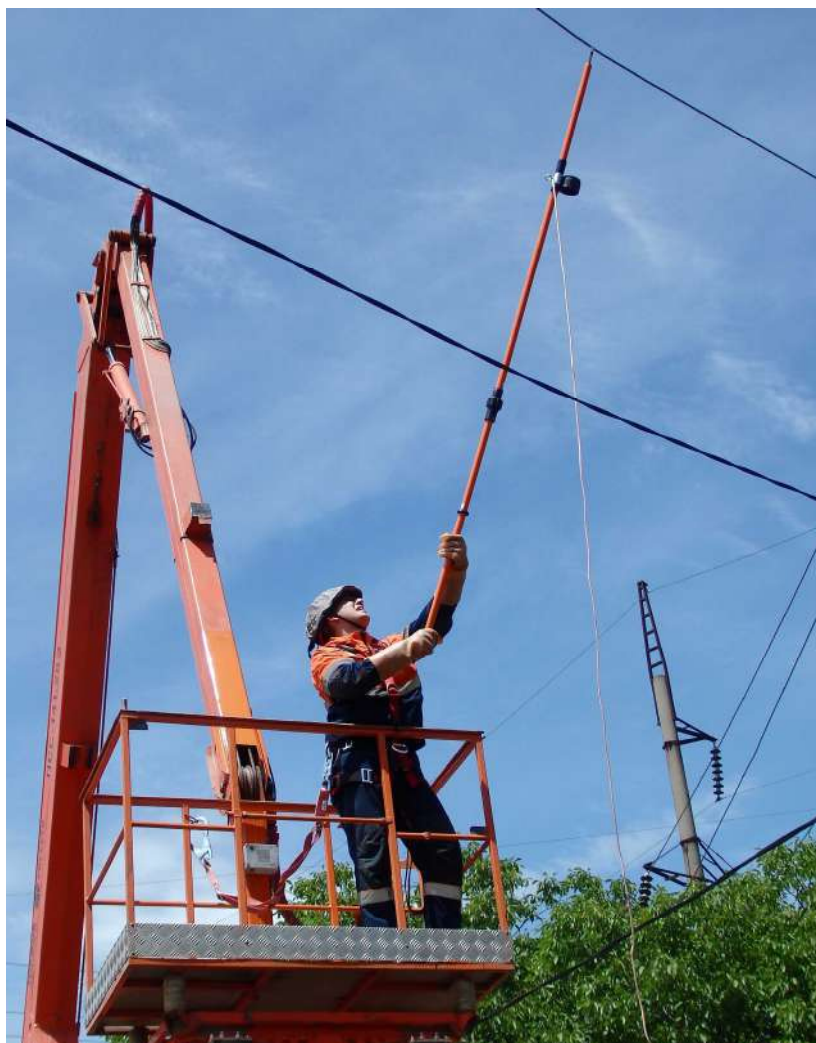
Рисунок 3.18 – Применение измерителя наведенного напряжения
