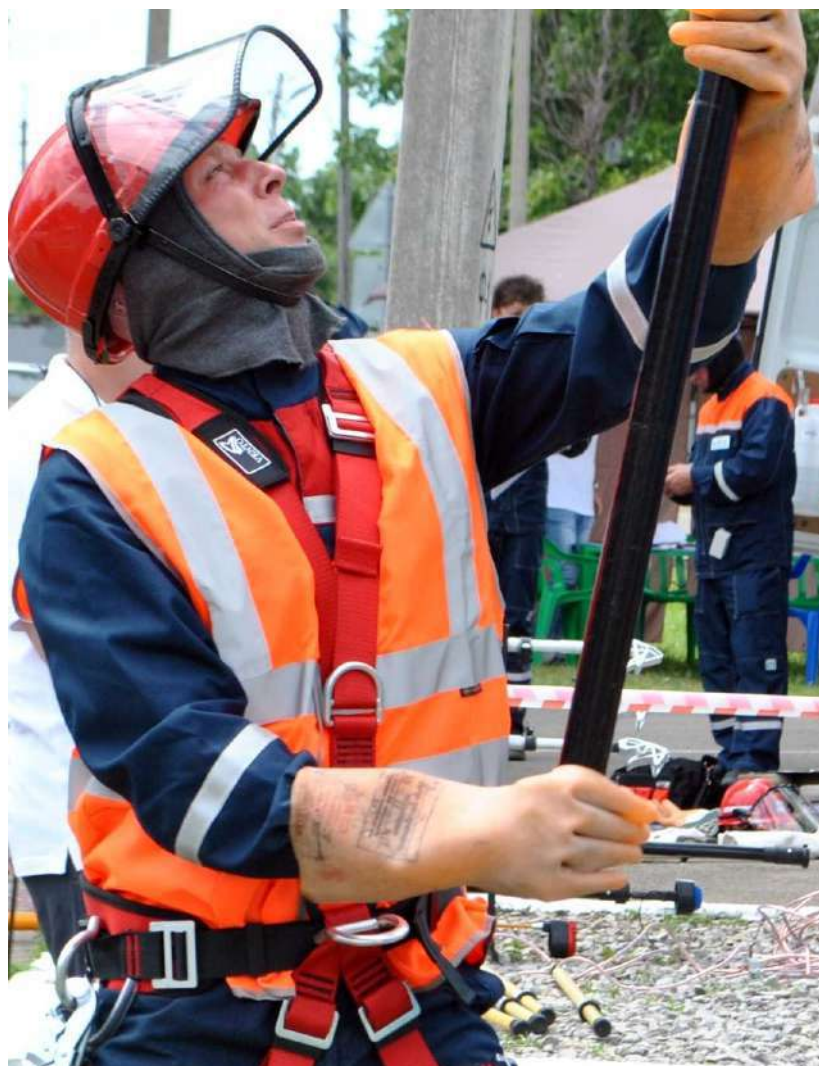
Рисунок 3.19 – Использование шунтирующего комплекта специальной одежды
