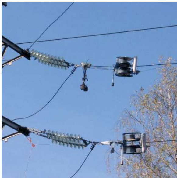
Рисунок 7.4.5 Протяжка навивочной машинки с помощью бензобуксировщика (сверху) и ручная протяжка (снизу)
