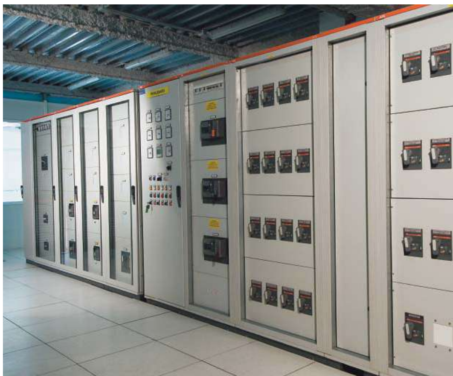
Рисунок 2.13: Главный распределительный щит (пример).
