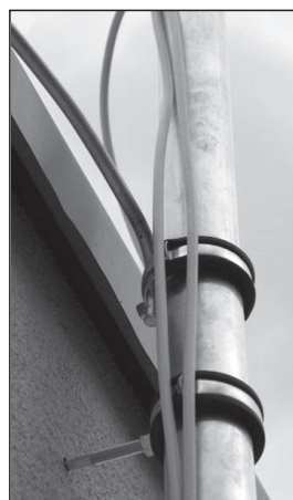
Рис. 11.17. Штанга телевизионной антенны, подключенная к контуру молниезащиты
