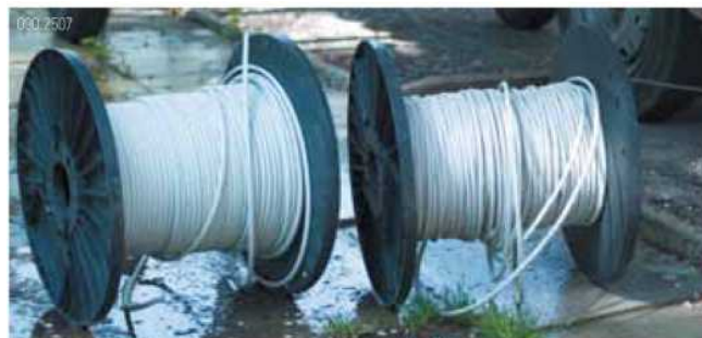
Неправильно: Кабели хранятся на открытом воздухе
