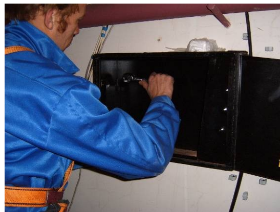
Рис. 9.1 - Пример установки антивандального шкафа
