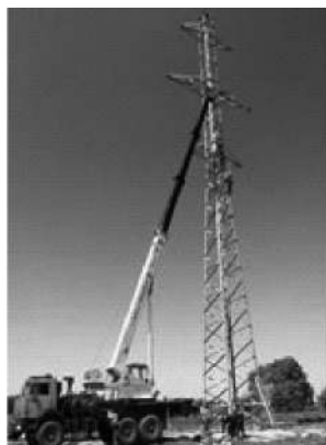
Рис. 4.2. Сборка металлических опор
