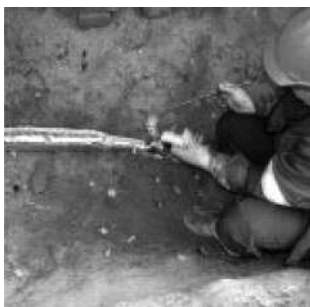
Рис. 12.8. Монтаж муфты СТП-10
