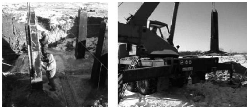
Рис. 4.1. Монтаж фундаментов под опоры ВЛ напряжением 110 кВ
